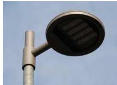
Bei dem Projekt kam die LED-Leuchte „RFL 534“ des Bispinger Herstellers WE-EF zum Einsatz. Die Steuerung der gesamten Anlage wird durch das System „Siteco Control“ verwirklicht. Die letztendliche Bestimmung der Anwesenheitssensoren für die Straßenbeleuchtung mussten die enercity-Techniker in zahlreichen nächtlichen Versuchen selbst herausfinden. An jedem Beleuchtungsmast ist ein Bewegungsmelder in drei Meter Höhe angebracht.
